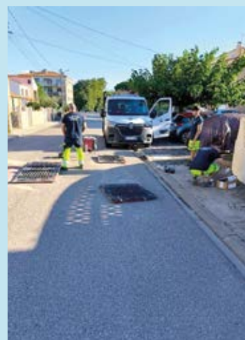
Pose de ralentisseur rue de l'Ensoleillé
