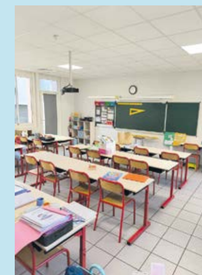
Réfection de la peinture de deux salles de classe
