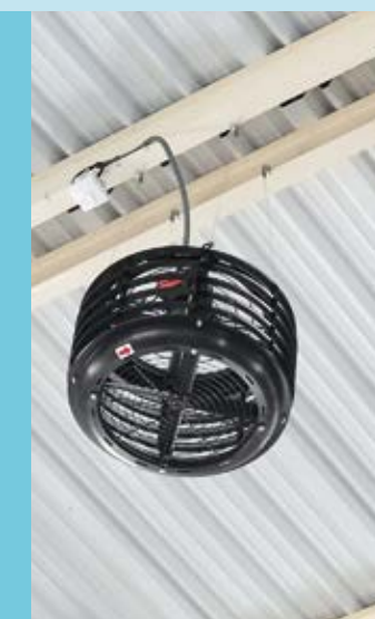
Réfection de la toiture de la salle polyvalente & pose d'un déstraficateur d'air
