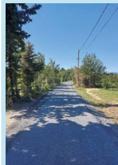
Rénovation de chemins communaux
