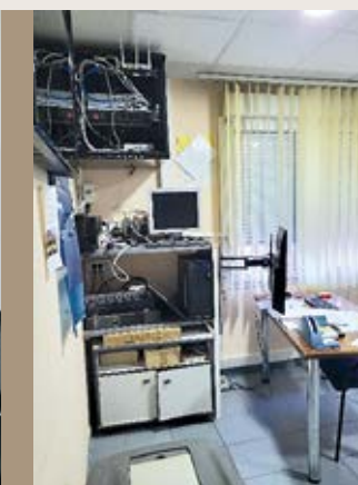
Séparation du bureau de la police municipale et du local caméras
