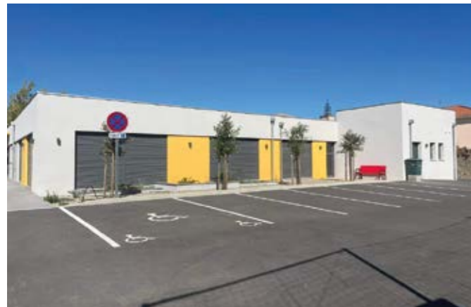
Extension du restaurant scolaire avec le concours financier de l'Etat (270 000 €), du Département (150 000 €), du SYM-PM (19 788,40 €) et de la commune (460 211, 60 €).
