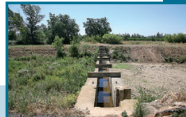
Canal d'irrigation sur le Castelnuou
