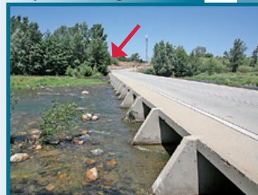
Échelle de crue de Pézilla-la-Rivière sur La Têt - D16A
