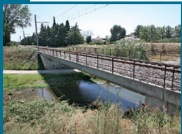
Pont de la voie ferrée sur le Castelnou
