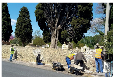
Réfection du mur du cimetière du bas
